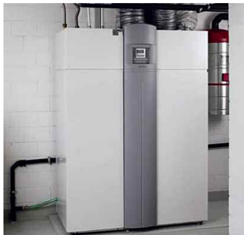
Die LWZ 303 bietet alle Effizienzvorteile eines Integralgerätes mit Lüftung, Heizung und Warmwasserbereitung.
